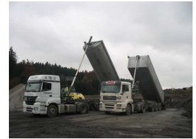
Parallel zum Bau des 1. Schlackefeldes wurden für den noch zu verfüllenden Bereich weiterhin Abfälle angenommen und eingebaut
